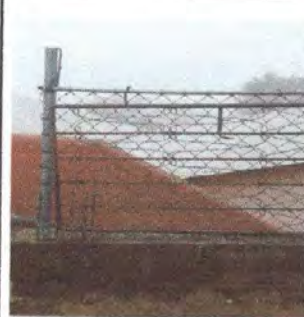
Foto 6: sustitucion de baranda de metal de deposito de agua
