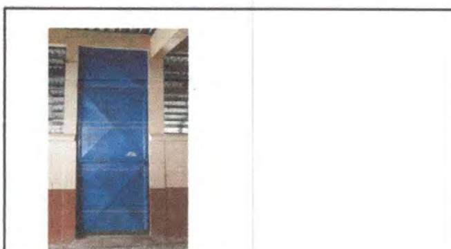
Foto 10: mantennimiento a estructura
