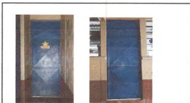
Foto 8: mantennimiento a estructura
