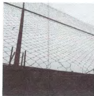
Foto 4: reparacion de muro perrimetral con tubo HG malla galvanizada solera intermedias y columnas
