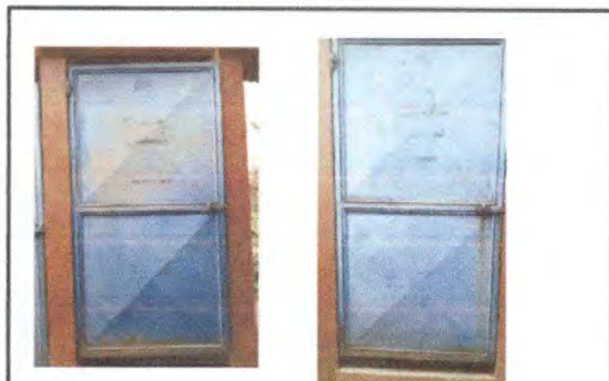
Foto 7: mantennimiento a estructura
