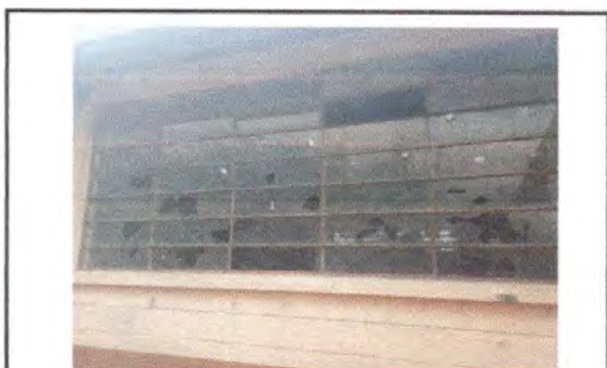
Foto 11: sustitucion de vidrios
